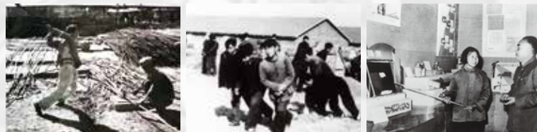
1954年, 永登水泥厂建设场景
