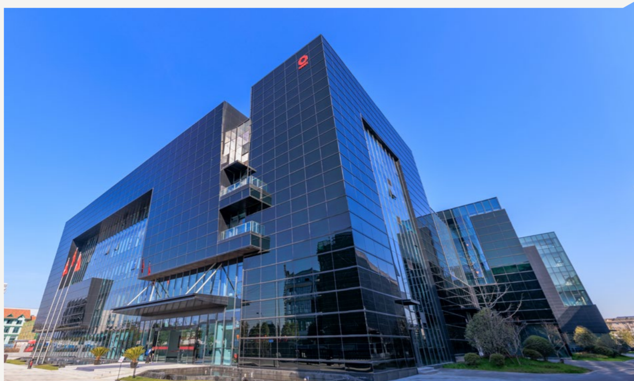
全国第一个城市中心的碲化镉发电玻璃综合集成项目——上海松江凯盛机器人大楼
