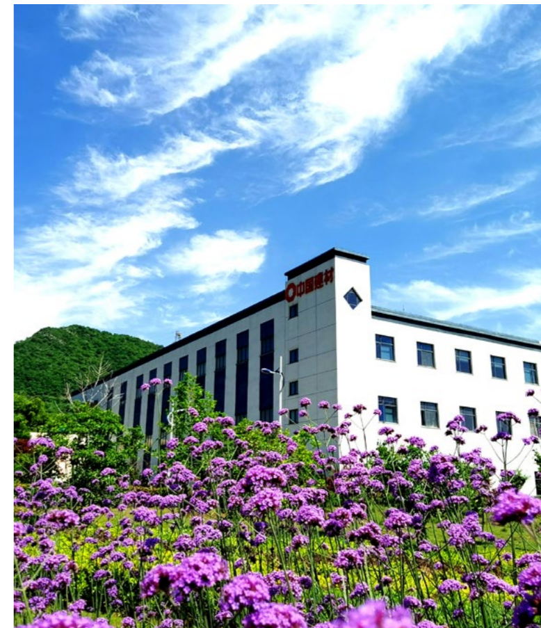
中材安徽水泥窑协同处置生活垃圾生产车间
