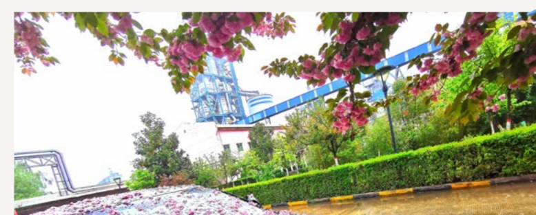
成县祁连山水泥厂景
