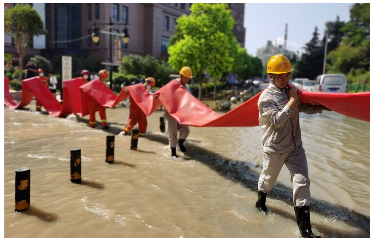
登封中联党员先锋突击队参与救援点排水管道铺设
