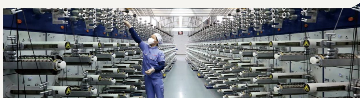
西宁万吨碳纤维基地荣获 2021 年度央企十大超级工程
