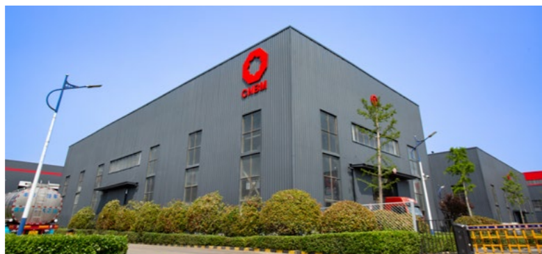
山东中岩厂区
