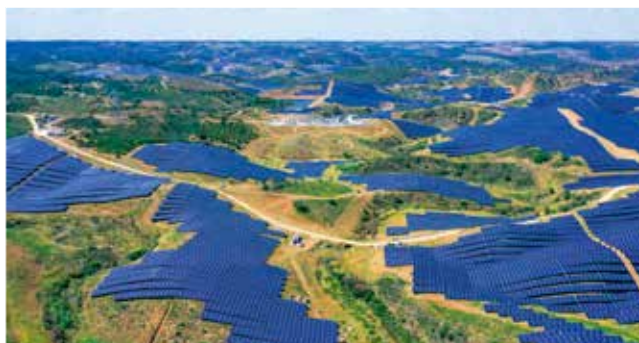
欧洲单体装机容量最大的光伏电站
