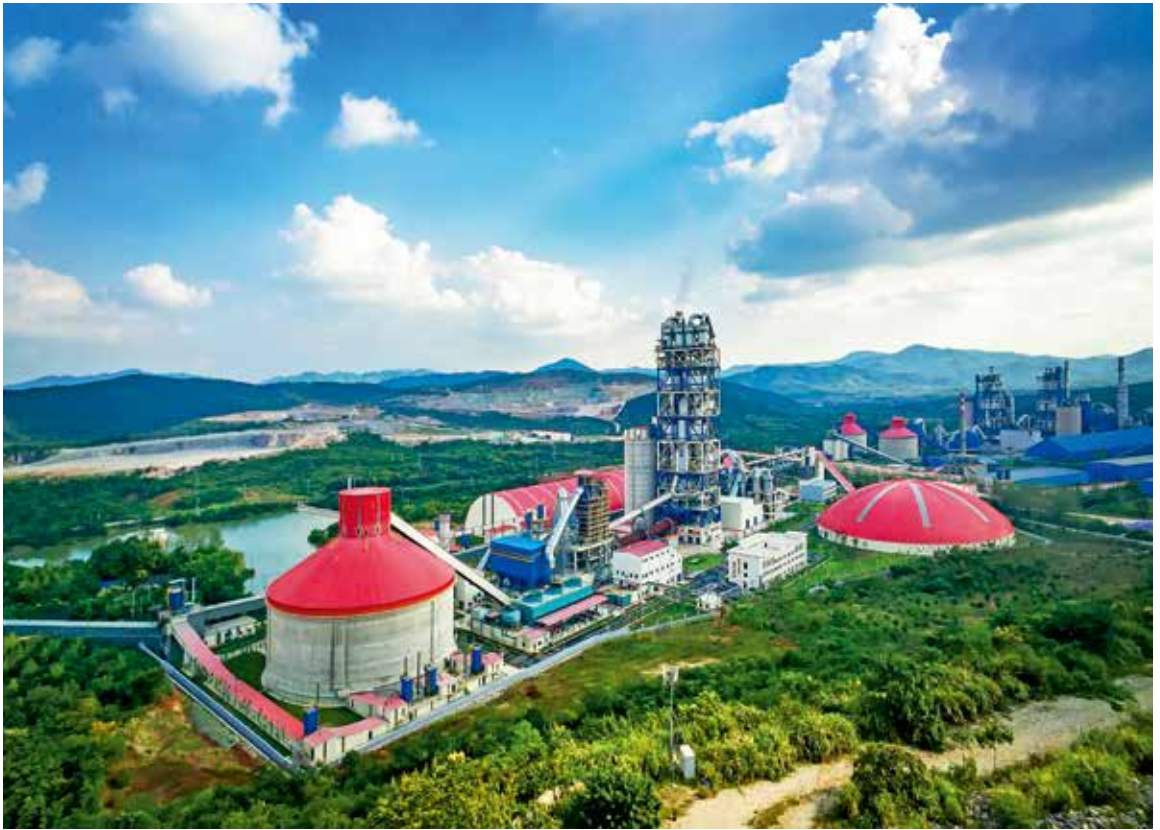
槐坎南方日产7500吨绿色化、数字化、智能化生产线
