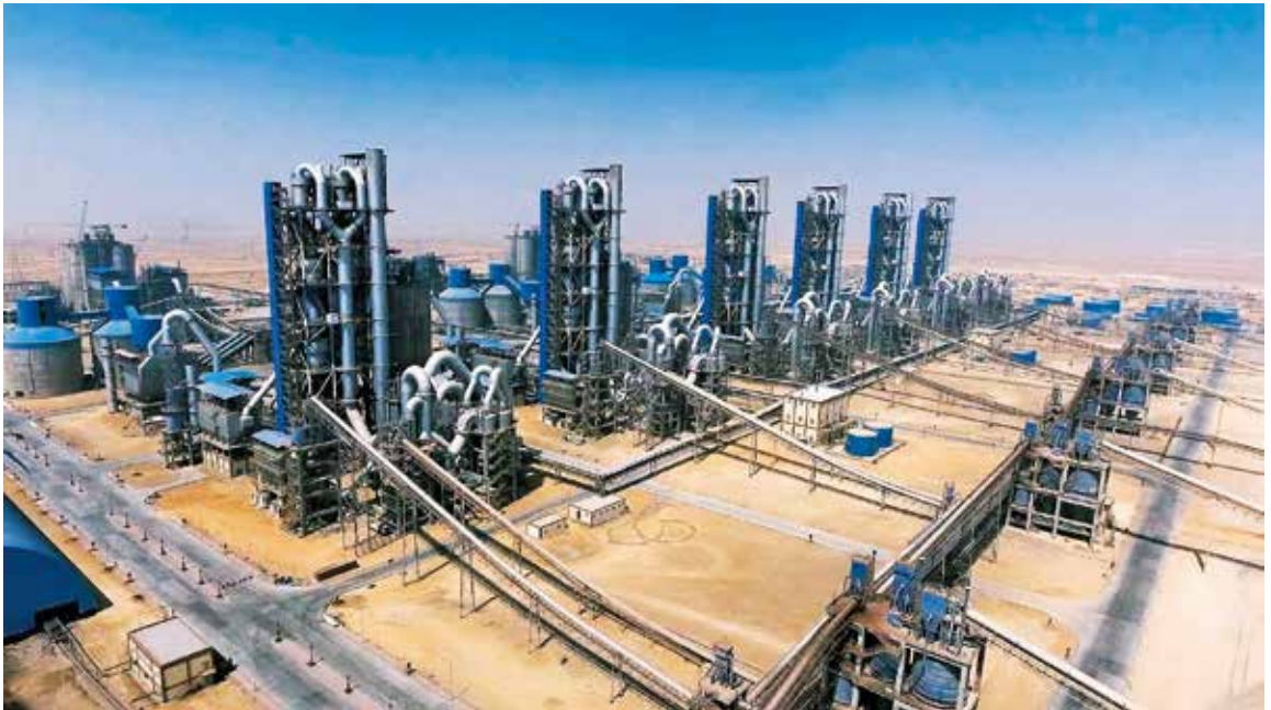
中材国际承建的埃及GOE项目
