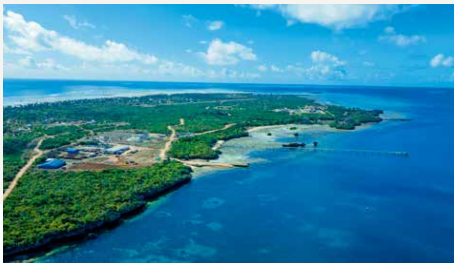
坦桑尼亚松戈岛天然气管道项目
