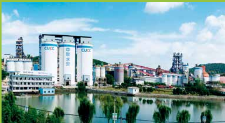
▼ 南京中联混凝土有限公司年产 300 万立方米技改（迁建）项目全景
