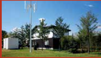
悬浮风机采用蓄电池储能系统，日发电量2kWh。
