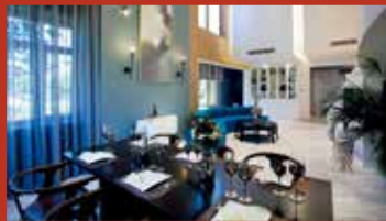
四台地源热泵提供室内22℃-25℃恒温，太阳能蓝膜热水系统，2块集热板、200L水箱。
