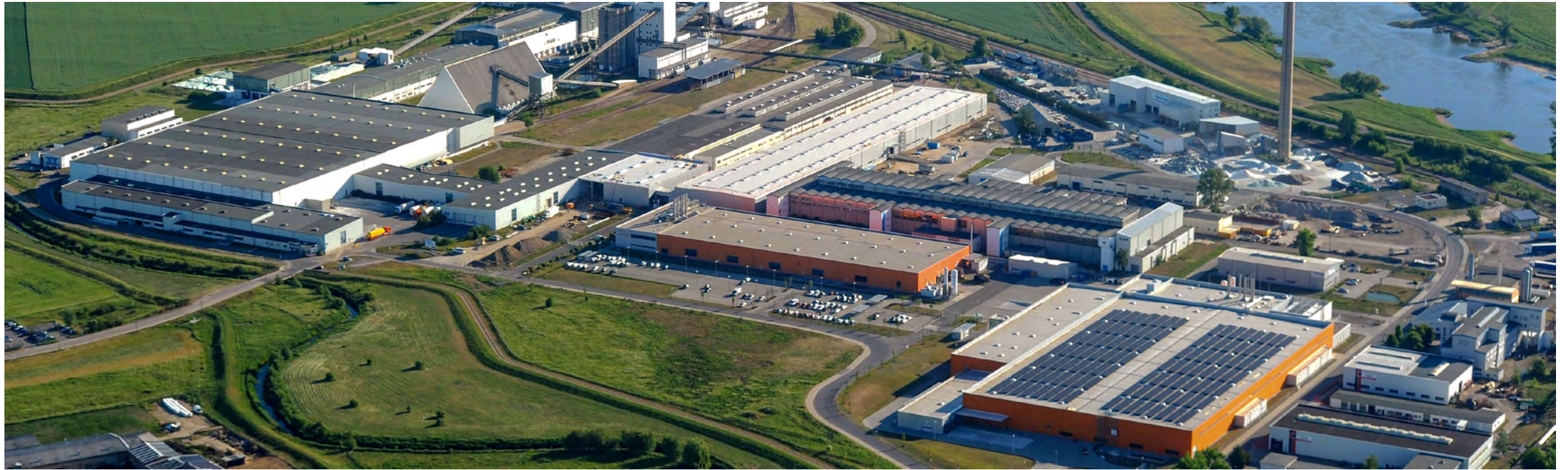
◎ 凯盛科技集团有限公司 Avancis 薄膜太阳能工厂
