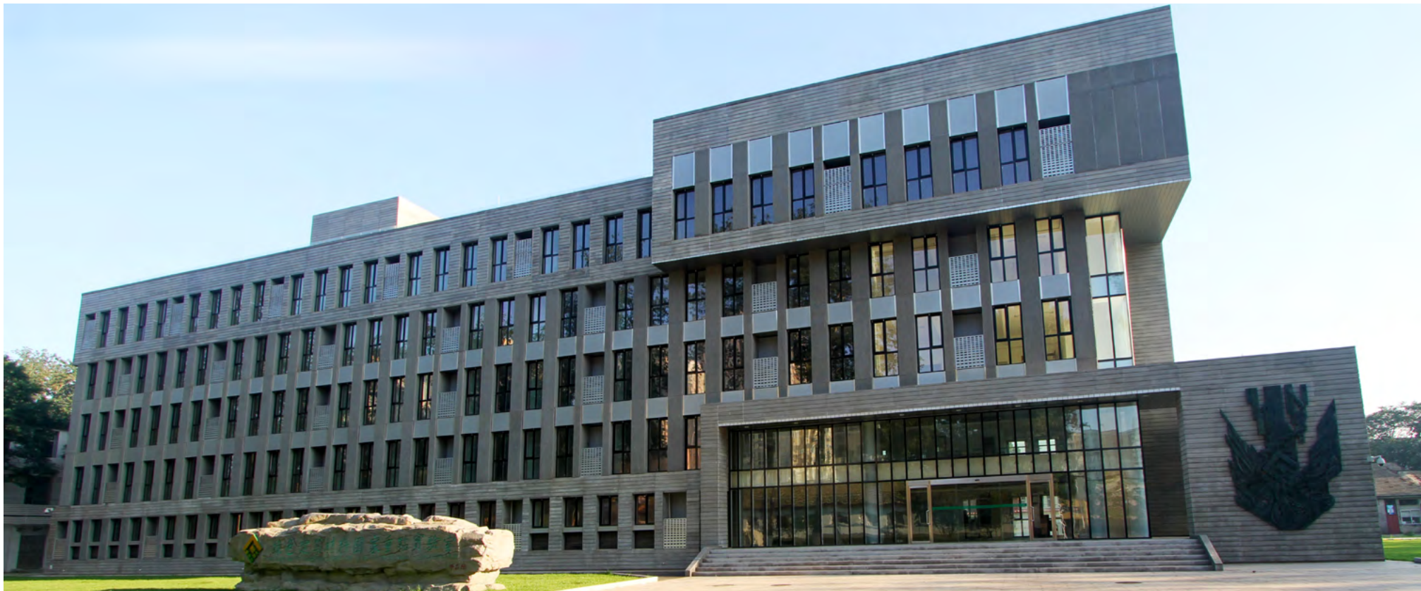
中国建材总院绿色建筑材料国家重点实验室
