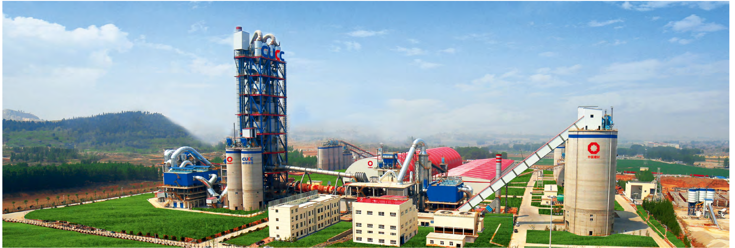
泰安中联水泥有限公司工业 4.0 智能化水泥工厂
