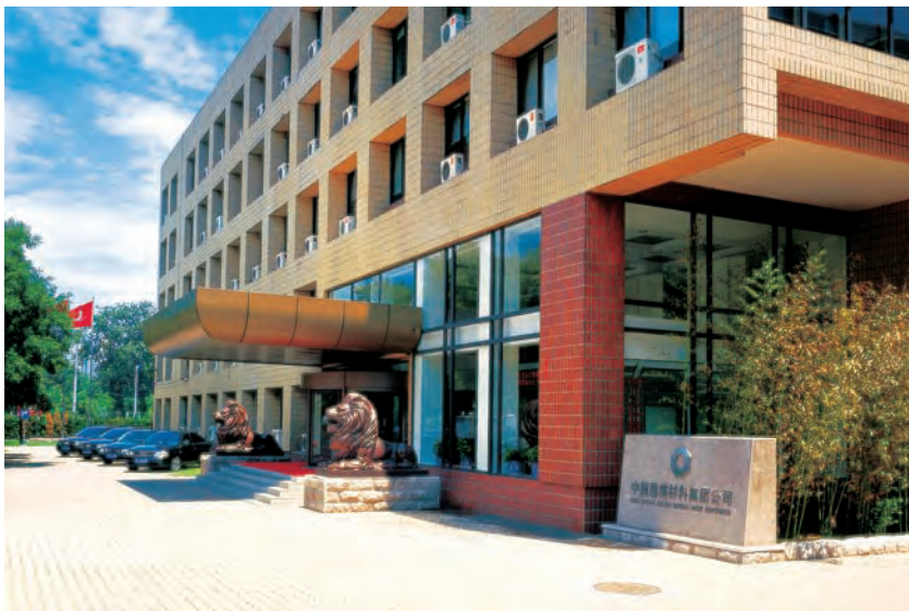
中国建材集团北京总部
