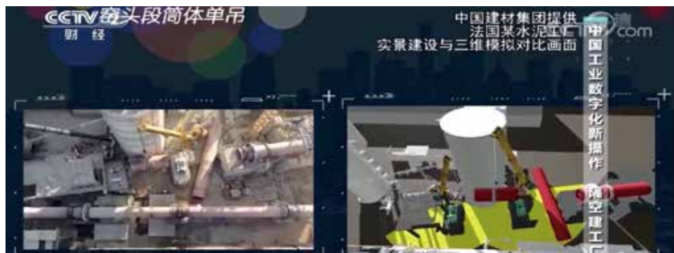
中国建材海外数字化“隔空建水泥厂”
