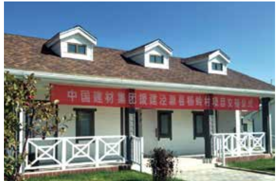
北新集团所属北新房屋承建的康养中心
