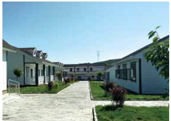
北新集团所属北新房屋承建的康养中心
