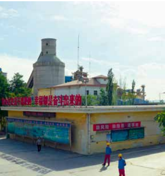
青铜峡生产区全景
