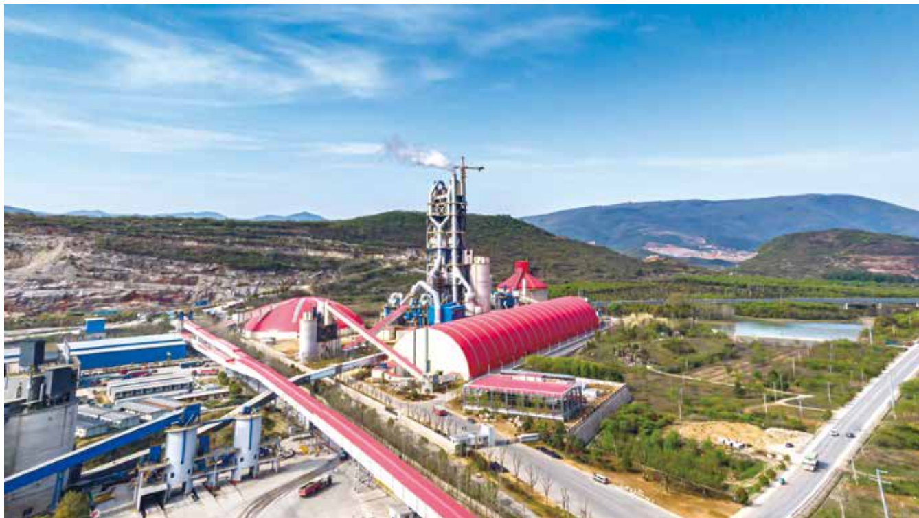
槐坎南方日产7500吨优化升级项目全景
