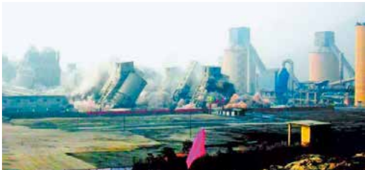
爆破9条机立窑水泥生产线
