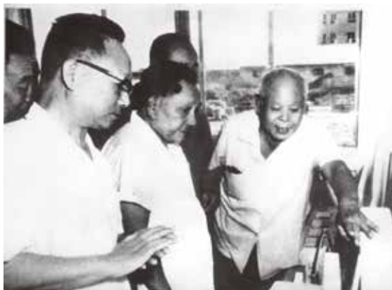
邓小平同志视察北京紫竹院新型建材试验房屋工厂
