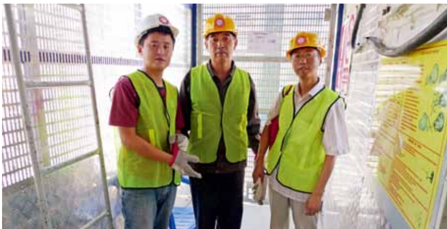
在施工升降机里维修
