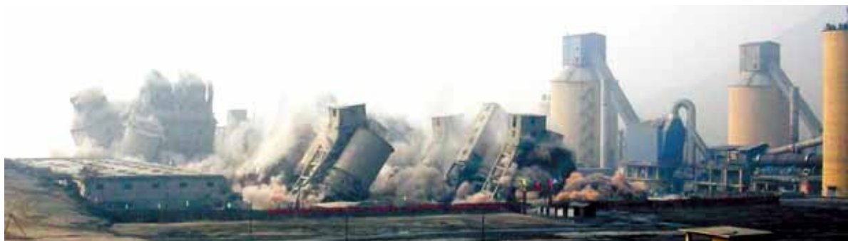
2007年,中国建材集团带头在枣庄集中爆破9条机立窑水泥生产线,被称为“中国水泥第一爆”
