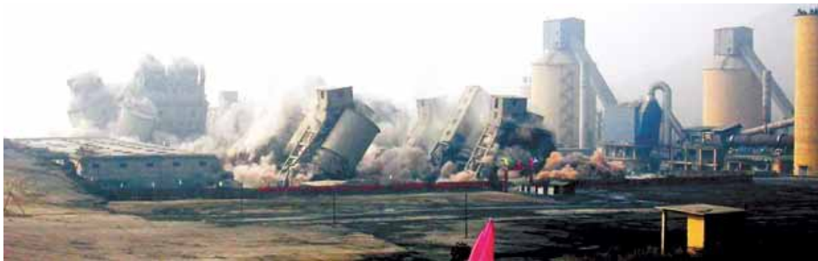
一举炸掉小立窑生产线，被称为“中国水泥第一爆”
