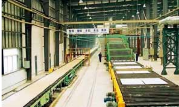
投产的北新建材太仓年产3000万平方米石膏板生产线
