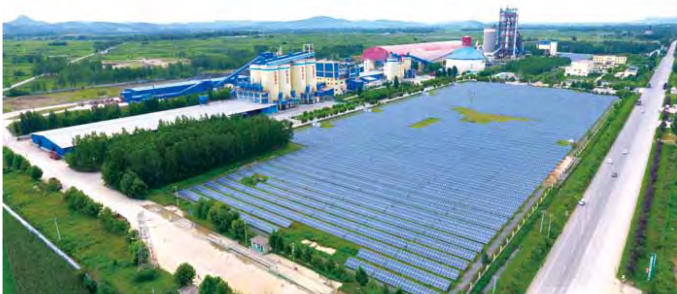
临沂中联打造的新能源水泥厂全景图
