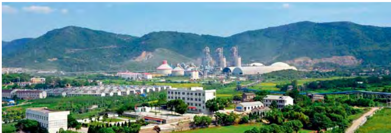
中材安徽水泥循环经济园远景
