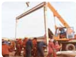
吊装第一个框架
