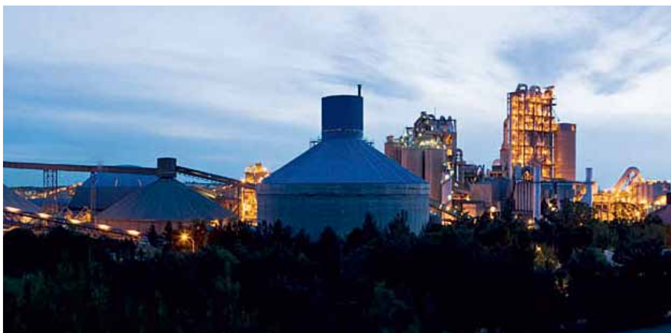
承建的德国海德堡土耳其日产6000吨水泥熟料生产线
