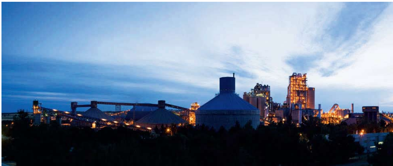
承接建设的海外水泥熟料生产线EPC工程
