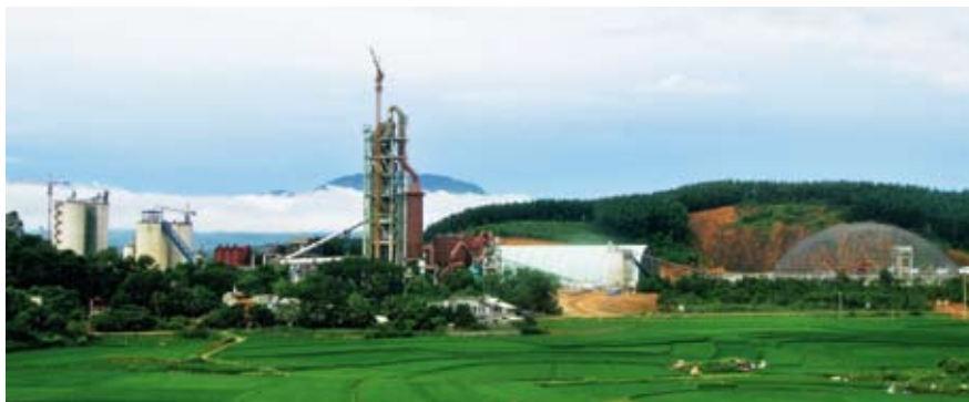
中国建材工程在越南新光建设的水泥生产线
