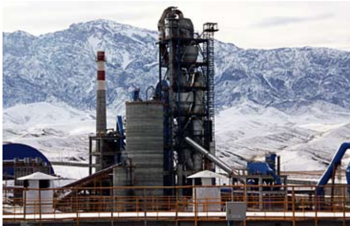
中国建材工程在吉尔吉斯斯坦建设的水泥生产线
