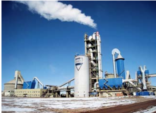
中国建材工程在哈萨克斯坦建设的水泥生产线
