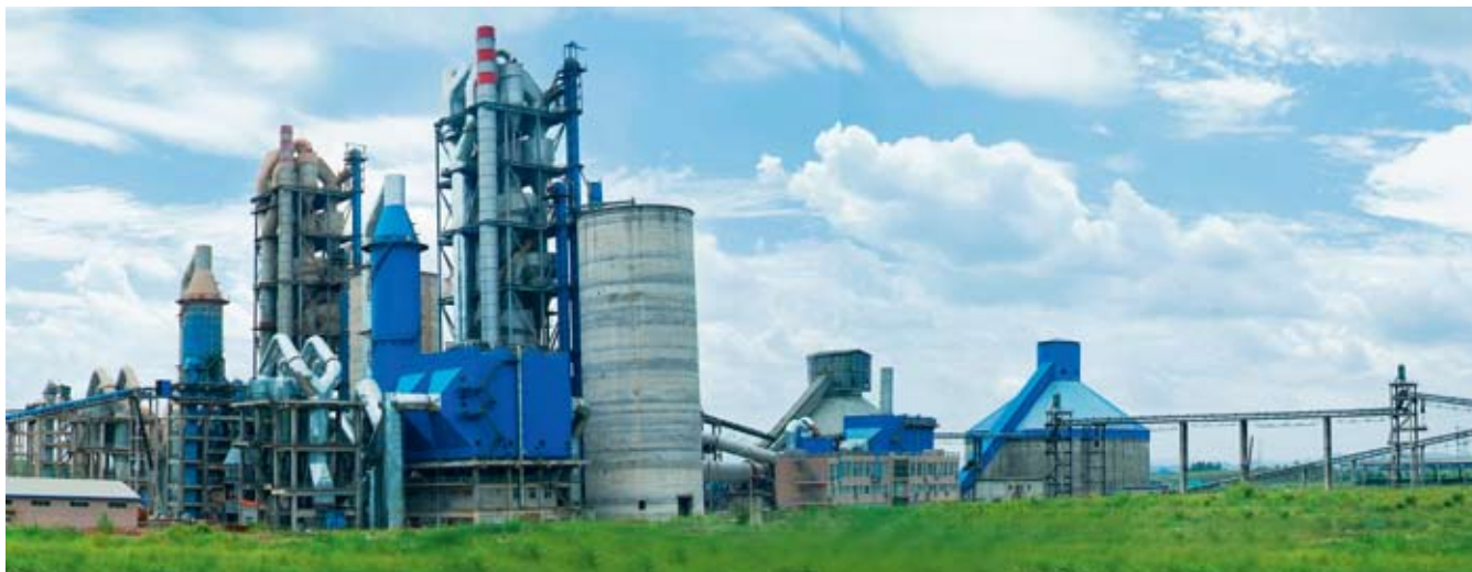
常山南方2条日产5000吨新型干法水泥熟料生产基地
