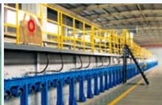
自主研发的全氧燃烧浮法玻璃生产线
