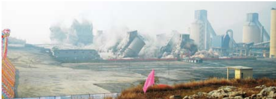
2007年中联水泥集中爆破拆除九条立窑生产线
