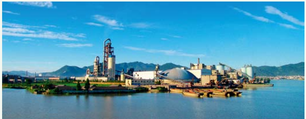
水泥企业污泥处理生产线
