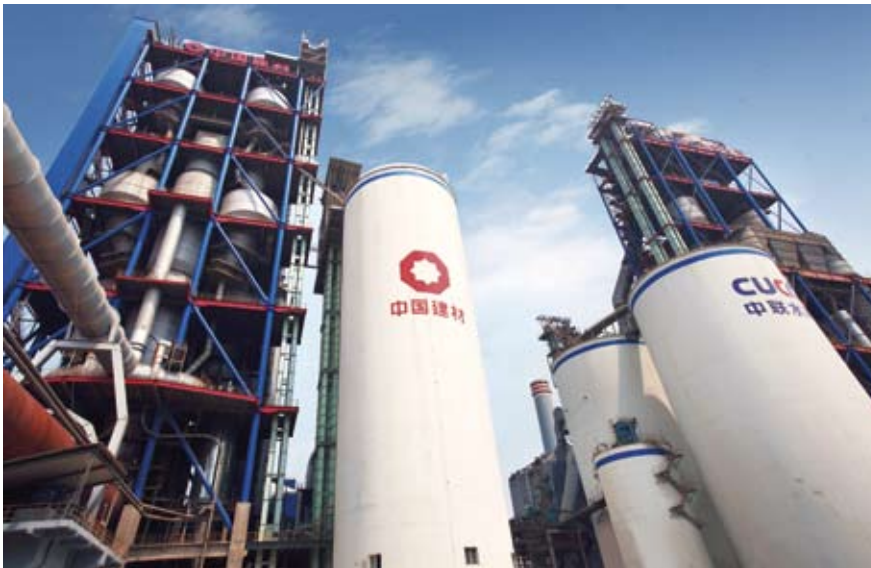
徐州中联双 万吨水泥生 产线
