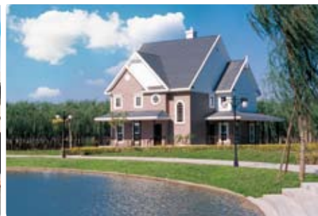
中国建材集团天津新型住宅示范区
