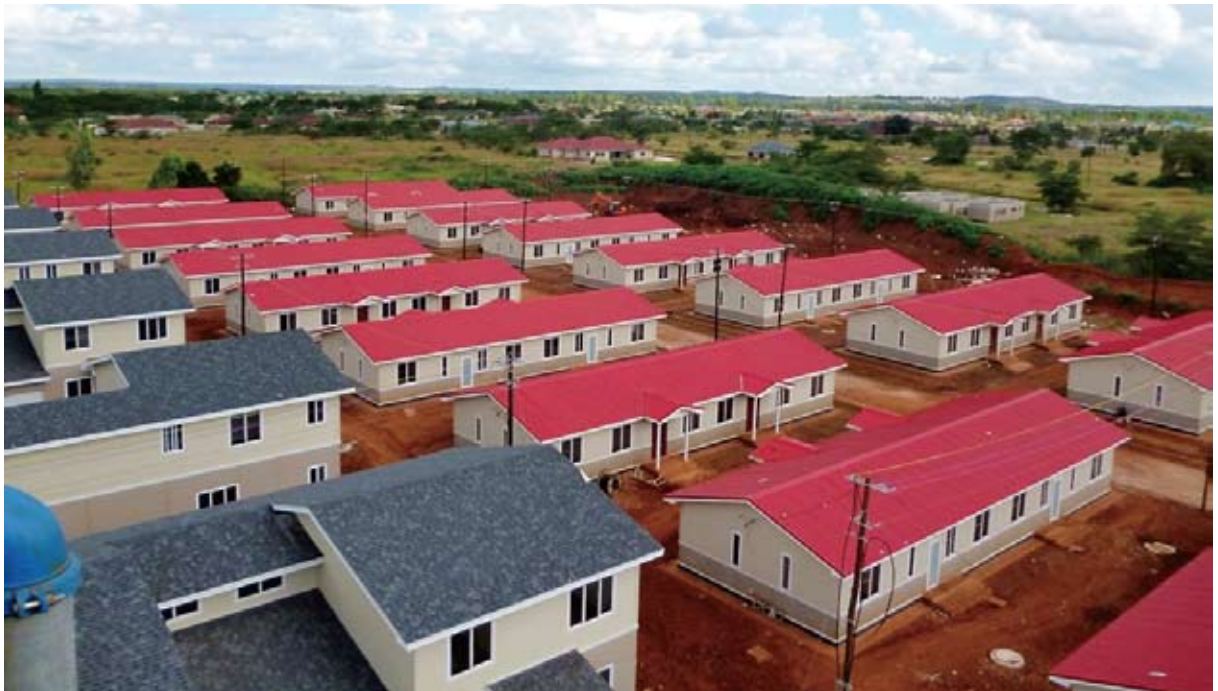
北新建材在赞比亚建设的公共住宅项目
