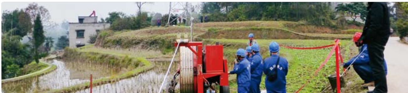
四川林洞线施工
