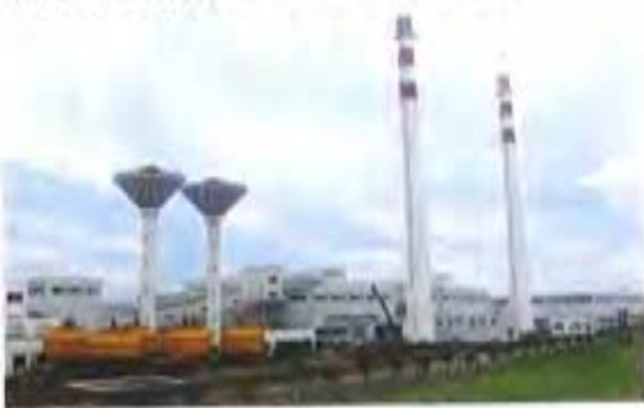
蚌埠院总承包的成都南玻500吨、700吨浮法玻璃生产线
