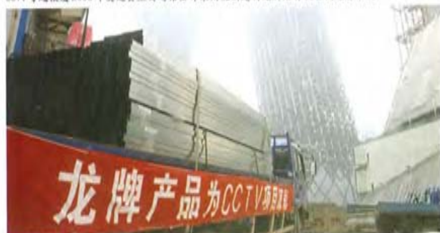
北新建材为CCTV新台址建设工地供货
